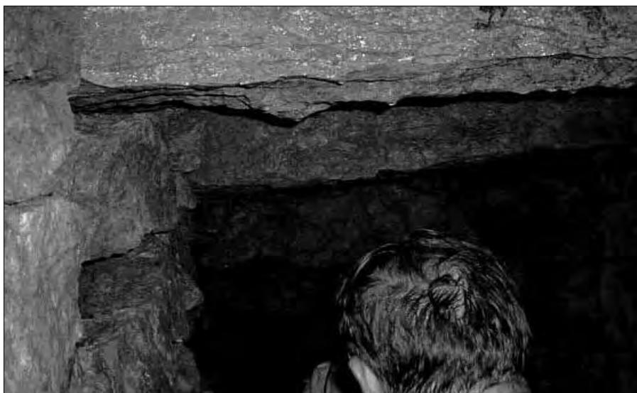
*Die Deckenkonstruktion besteht aus behauenen Tragsteinen, die sauber aneinander gefügt sind, dass kaum ein Zentimeter Luft zwischen ihnen ist. Hier: etwa in Höhe der Deckenstufe (Foto: Geise)*
